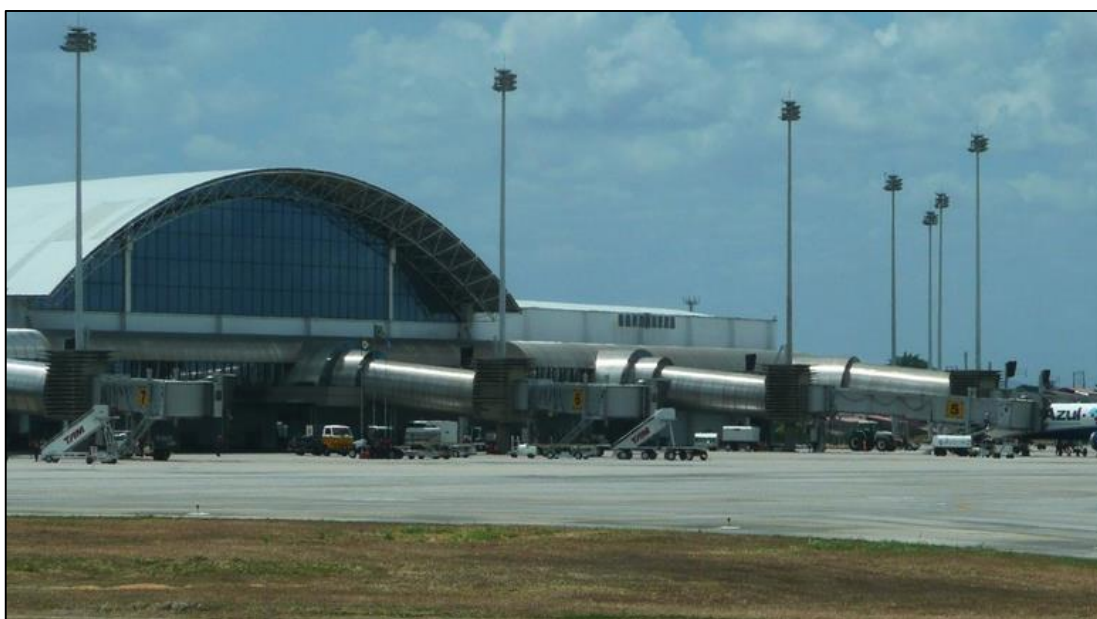
Figura 13: Pontes de embarque de passageiros do Pátio 2
