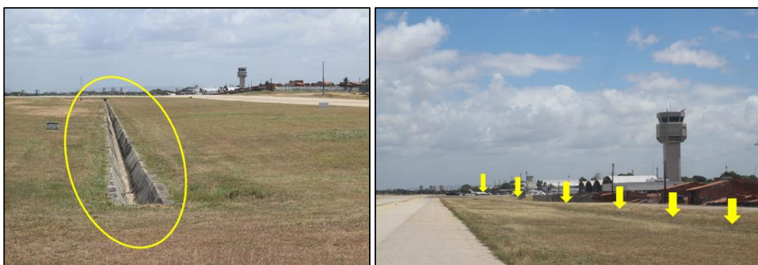
Figura 39: Localização das canaletas de drenagem
