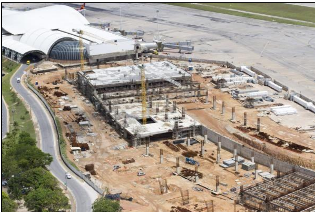
Figura 18: Situação atual das obras de ampliação do TPS do Aeroporto
