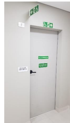
Porta da saída de emergência
