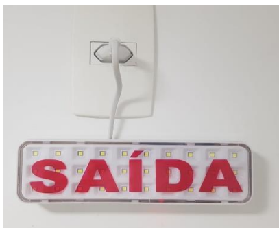
Luminária de emergência
