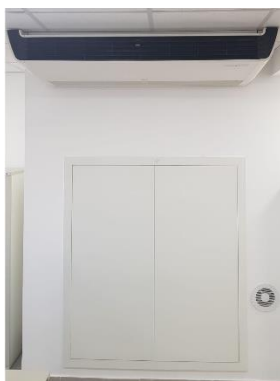
Instalação de aparelho split
