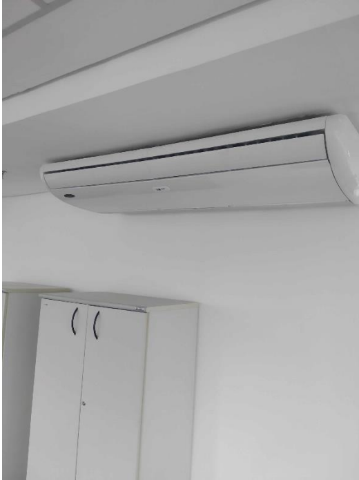
Instalação de aparelho split
