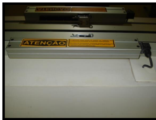
Foto 8: Mecanismo de abertura de janelas
