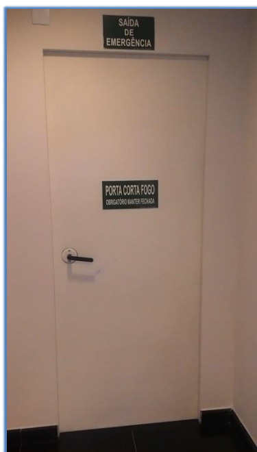
Foto 06: Porta da saída de emergência
