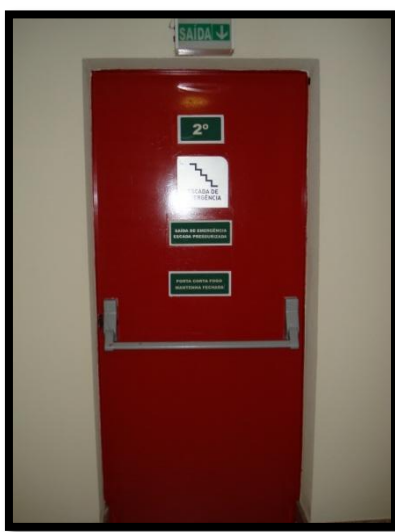
Foto 9 – Porta da saída de emergência
