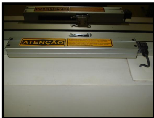
Foto 8 - Mecanismo de abertura de janelas
