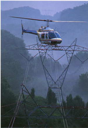
Inspeção de linhas de transmissão
