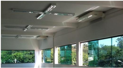
Foto 8: Instalação de aparelho split
